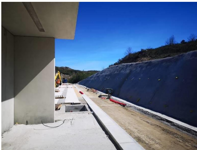
Figura 40 – Apeadeiro de Maçainhas em obras de requalificação Fonte: Levantamentos de campo de 10 de março de 2020
