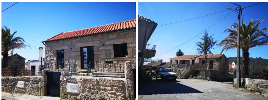
Figura 51 – Exemplos do tipo de construção em Olas Fonte: Levantamentos de campo de 10 de março de 2020
