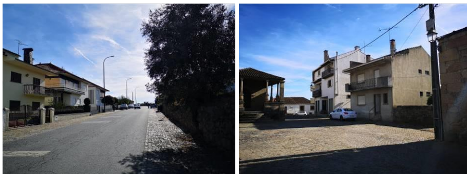
Figura 24 – Exemplos da tipologia do edificado em Caria Fonte: Levantamentos de campo de 10 de março de 2020
