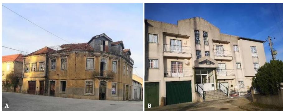
Figura 11 – Exemplo das antigas construções (A) e novas construções (B) Fonte: Levantamentos de campo de 10 de março de 2020
