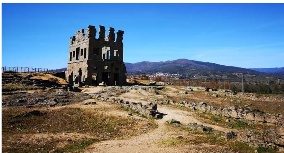
Figura 19 – Centum Cellas , em Catraia da Torre Fonte: Levantamentos de campo de 10 de março de 2020
