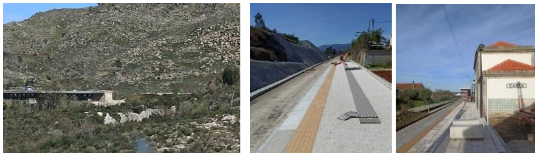
Figura 17| Obras de remodelação da Ponte e Apeadeiro de Maçainhas, e Caria
