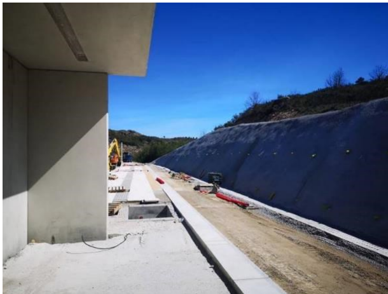
Figura 109| Apeadeiro de Maçainhas em obras de requalificação
