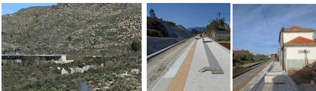
Figura 160| Obras de remodelação da Ponte e Apeadeiro de Maçainhas, e Caria
